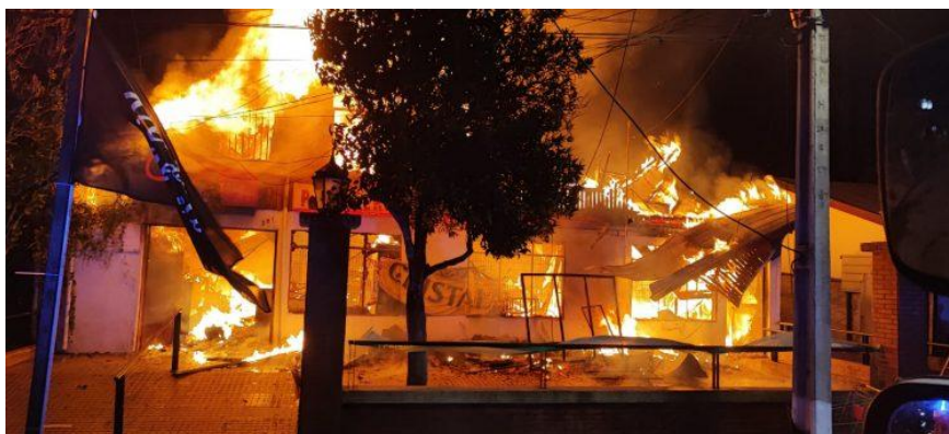
Incendio supermercado centro de Ninhue, 17 de agosto 2024.
