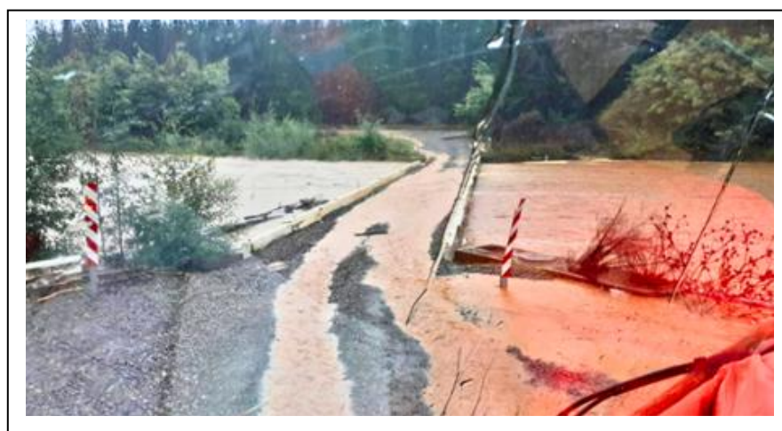
Imagen 8. Puente Cajones junio 2024.
